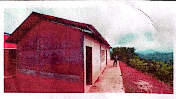
Foto 4: Se necesita el entechado y entortado del corredor
